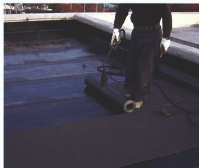
平場部の施工
