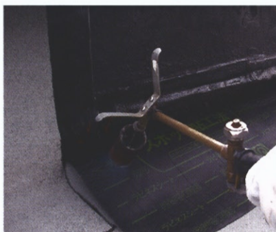
立上り部の施工
