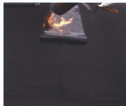
通気シートの短辺処理
