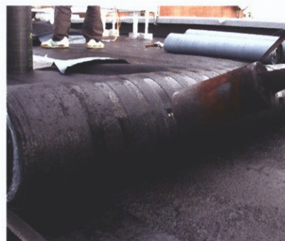
通気シートの施工
