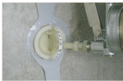
⑧注入・養生
